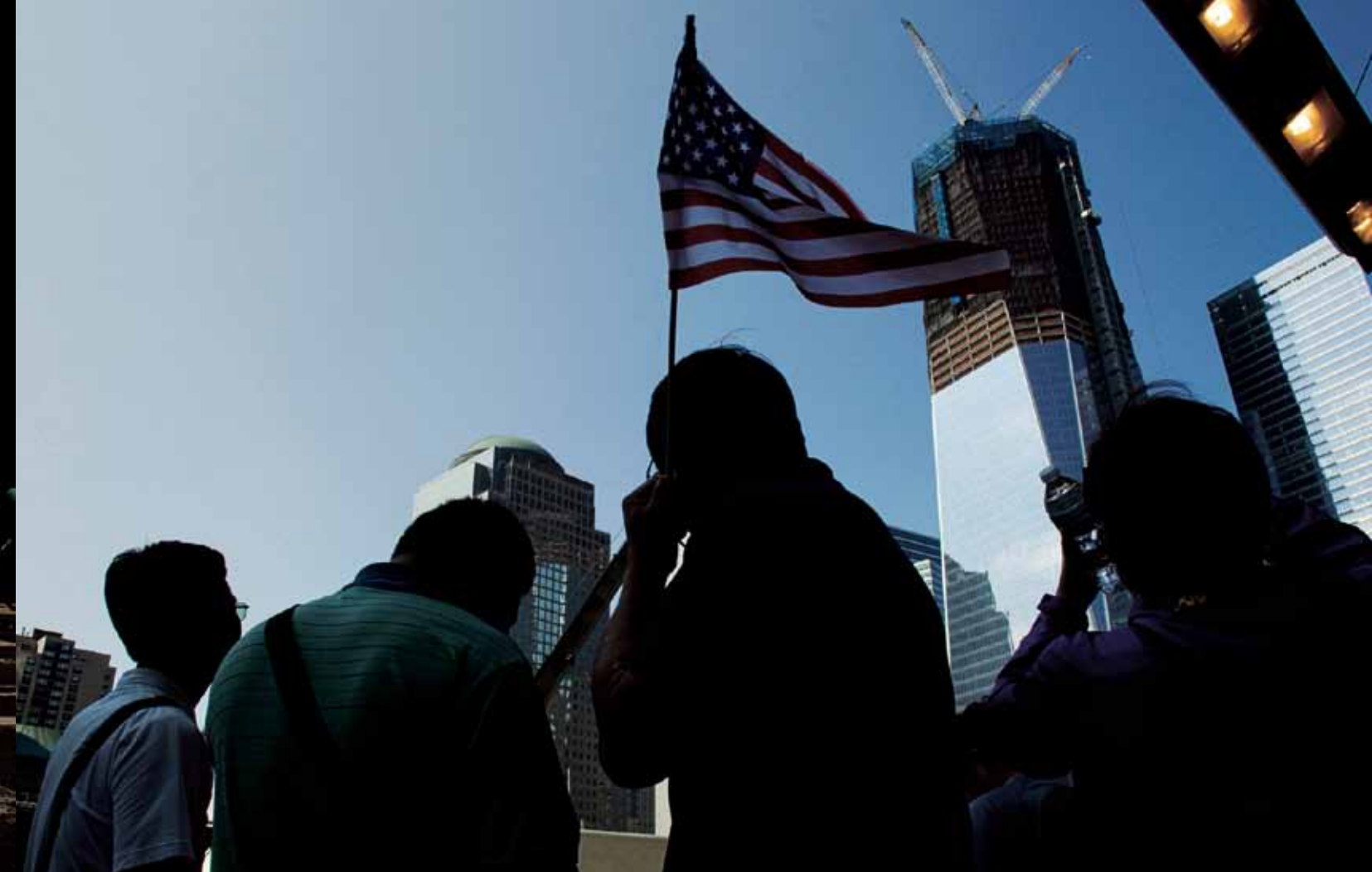
WTC-alueen reunalla Freedom Towerin rakentaminen on yhä kesken erinäisten kiistojen vuoksi. Monet muistuttavat, että Empire State Building, Manhattanin korkein rakennus, rakennettiin alle kahdessa vuodessa 1920–30-lukujen vaihteessa.
